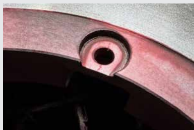
Grietas en la superficie en la ubicación de montaje de los pernos
